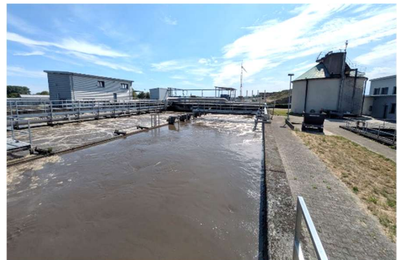
Bild 4: Belebungsbecken und Schlamm-Silo
