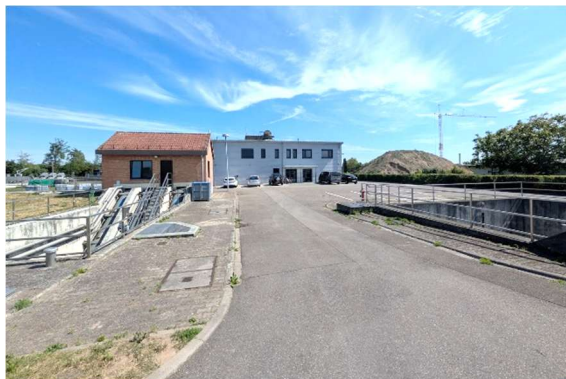
Bild 3: Eingangsbereich mit Verwaltung und Hebewerk
