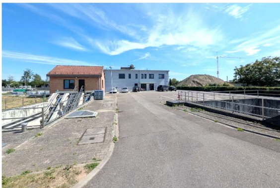
Bild 3: Eingangsbereich mit Verwaltung und Hebewerk
