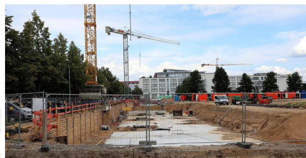
Neues Quartier: In Oberreit baut die städtische Volkswohnung bis Ende 2023 rund 170 neue Wohnungen. In den vergangenen Jahren hat die Bautätigkeit in der Stadt nicht gereicht, um den Bedarf zu decken. Foto: Jörg Doncker
