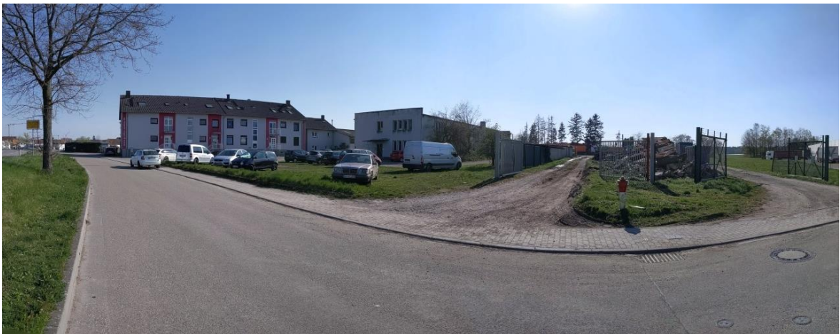
Bild 4: Plangebiet von Nordwesten mit Erschließungsstraße im Vordergrund
