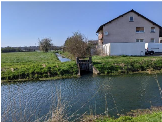
Bild 5: Einmündung Pfinz in Pfinzkanal
