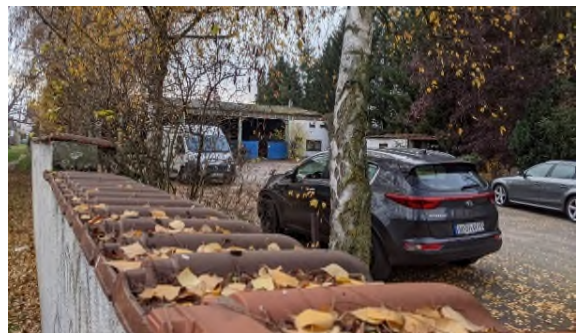
Bild 5: Gewerbebehalde mit Einfriedung
