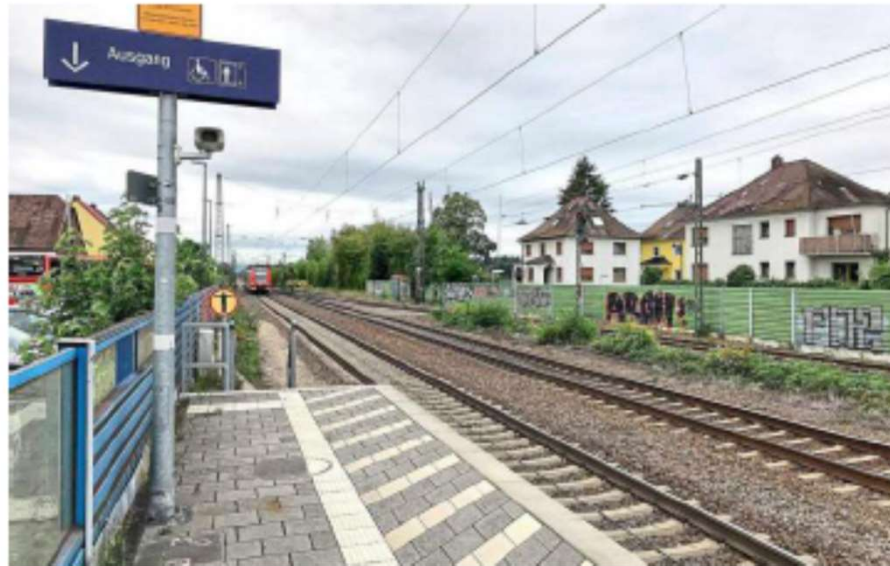
Platz für neue Gleise? Die Bahn will die Kapazitäten zwischen Mannheim und Karlsruhe (das Bild zeigt Blankenloch) erhöhen. Die Trassensuche ist schwierig. Foto: Rake Hora
